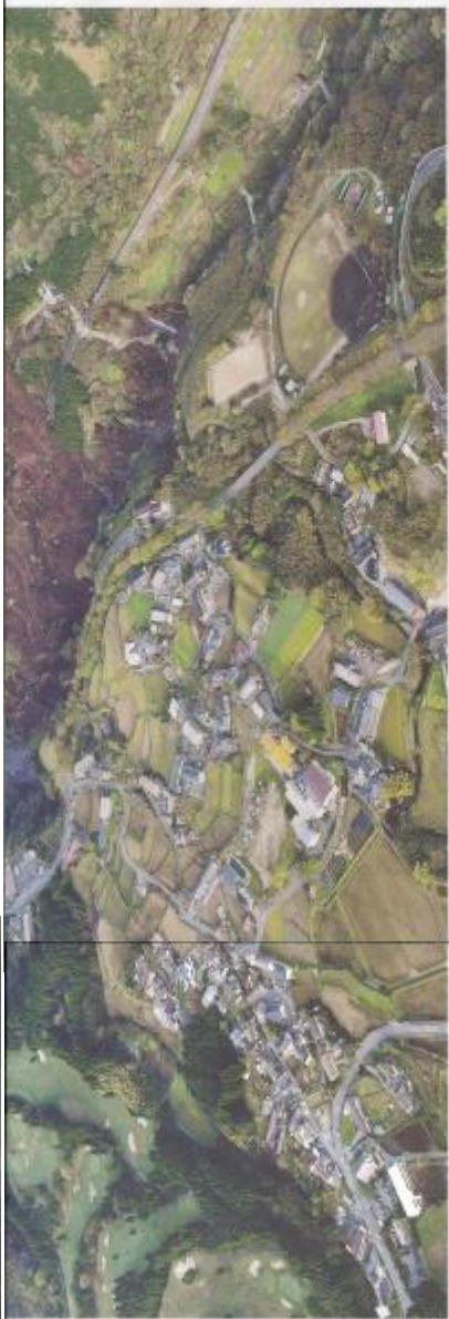
地震の被害を受けた南阿蘇村。崩壊した土砂崩れが原因で、阿蘇大橋が崩壊した。16日午前9時40分
